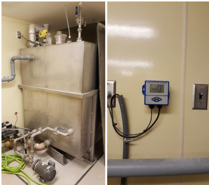
Figuur 9 Effluent tank (links) en pH meter die pH in de effluent tank reguleert (rechts)
