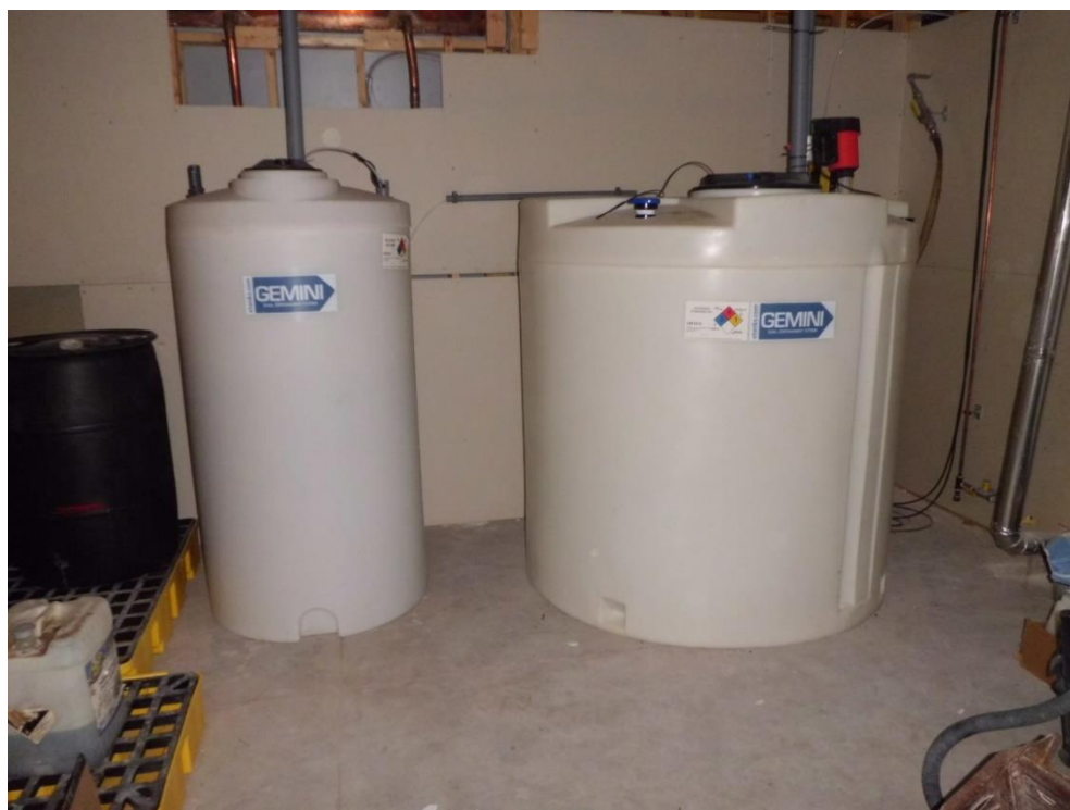
Figuur 12 Zuur ( \text{H}_2\text{SO}_4 ) en Alkali of Loog (KOH) tanks.
